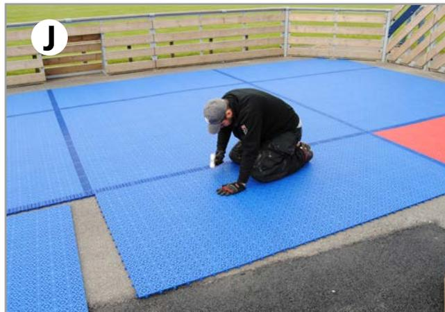
6. Die Verbindungsringe müssen immer in die gleiche Richtung verlegt werden.
